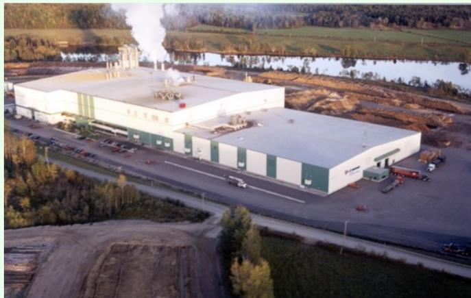
L'usine se spécialise dans la production de panneaux lamellés orientés qui sont utilisés dans la fabrication de planchers de maison, de revêtements extérieurs, de panneaux d'isolation, de fabrication de meubles et de poutrelles. L'usine a une capacité de production quotidienne de 55 000 panneaux, soit l'équivalent de la construction de plus de 250 maisons. Cette production permet de desservir le marché canadien et nord-est américain.
